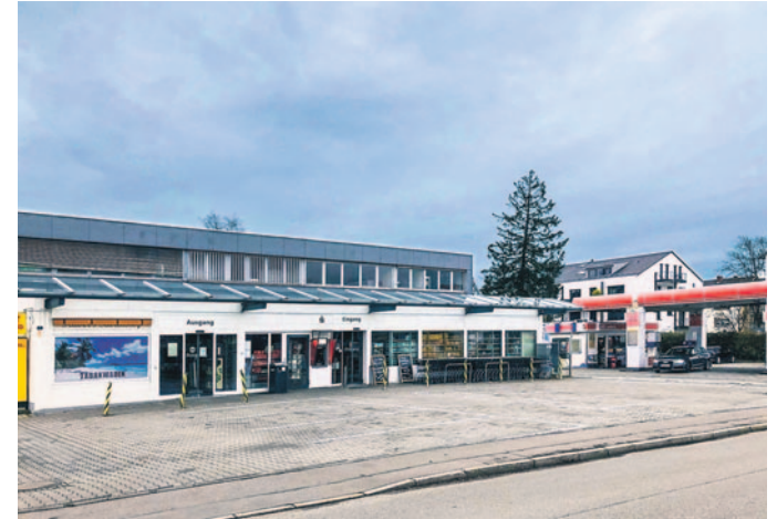
Auf dem Gelände des Amper-Einkaufszentrums (AEZ) und der benachbarten Tankstelle wird ein dreigeschossiges modernes Einkaufszentrum entstehen.
